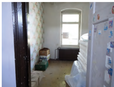
Wohnräume im Bahnhof
