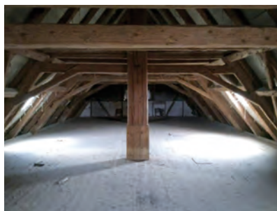
Dachstuhl im Kornhaus
