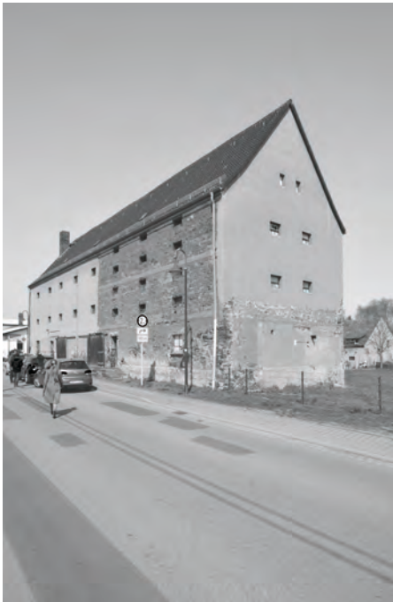
heutiger Zustand des Kornhaus Thallwitz
