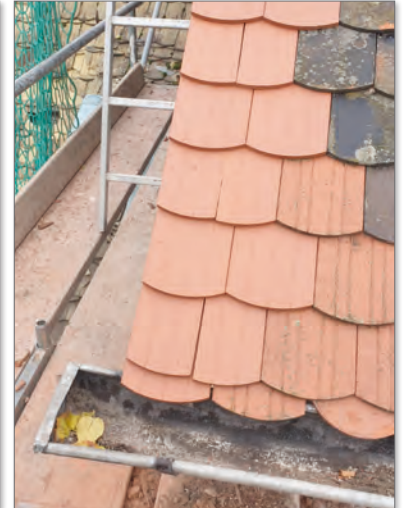
Dachnotsicherung – nachher (Foto: T. Winkler 24.11.2020)
