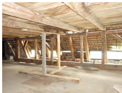
Dachstuhl der Alten Brauerei
