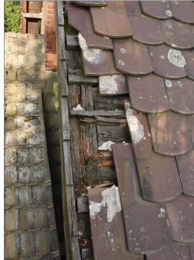
Dachnotsicherung – vorher (Foto: T. Reinsch, 27.7.2020)
