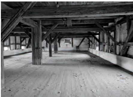
Bestandsanalyse | Schutzstruktur im 1. OG
