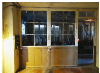
Baudetail in der Bahnhofswerkstatt
