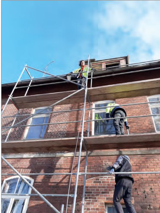
Gerüstbau in Eigenleistung, rechter Seitenflügel, Straßenseite 26.11.2021
