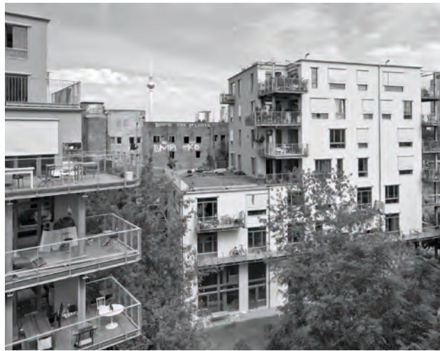
Die privaten „vertikalen Gärten“ und Gemeinschaftsterrassen, die sich über alle 3 Baukörper ziehen
