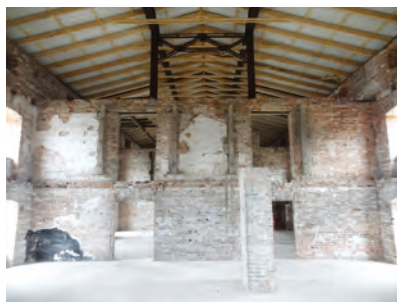
Obergeschoss Alte Brauerei
