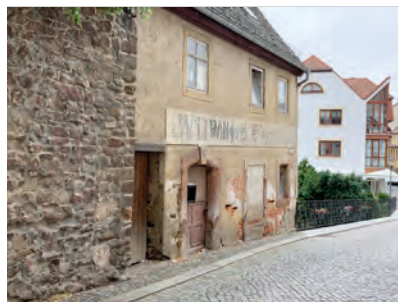
Historische Bausubstanz in Colditz ...
