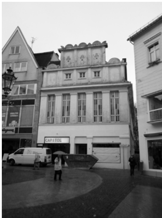
An der südöstlichen Ecke des Kirchplatzes erstrahlt die Fassade des ehemaligen Kino Capitol in neuem Glanz (links vor und rechts nach der Sanierung, Quelle: Stadt Lüdenscheid).
