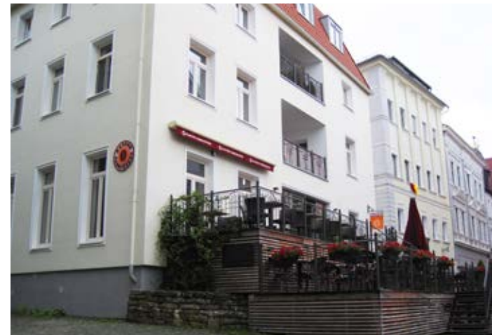
Das „Kaffee Fabriksken“ (oben die Brandwand vor dem Umbau, Quelle: Stadt Lüdenscheid; unten das Gebäude nach dem Umbau, Quelle: IRS)
