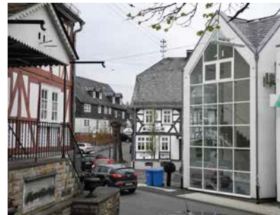
Das Parkhaus ist integraler Bestandteil der Aufwertung des Ortszentrums und wurde in unmittelbarer Nähe der Römerpassage und des ältesten Hauses im Ort, der Alten Vogtei, errichtet. (Architektur: Büro Halbach, Neunkirchen, 2000)
