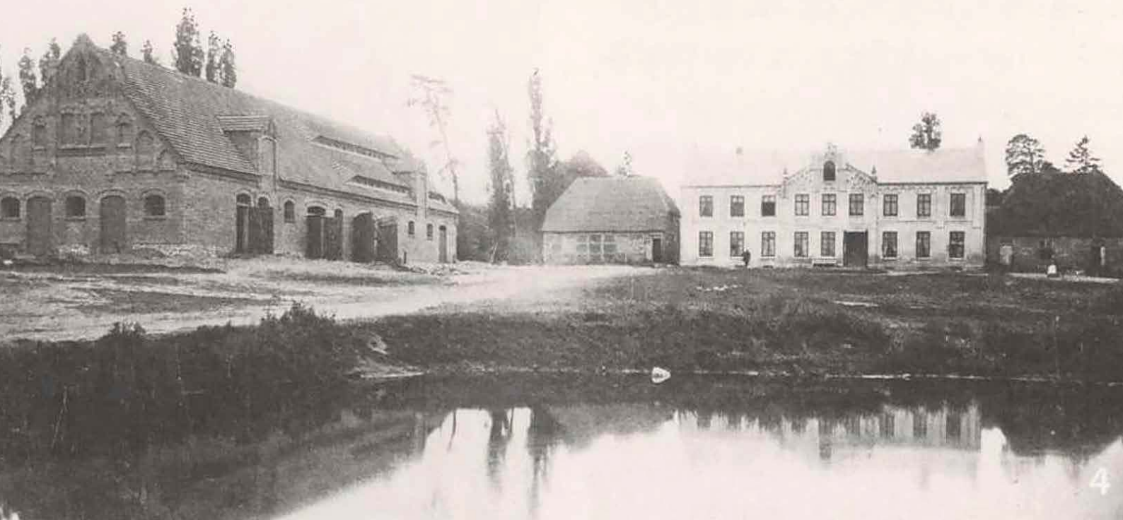
Das alte Gutshaus in Lüchow (ca. 1860)
