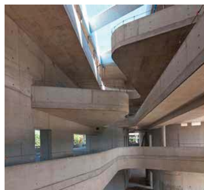
Eines der größten aktuellen öffentlichen Bauprojekte der Stadt ist der Neubau einer sechszügigen Realschule mit Ganztageeinrichtung und Sporthalle. (Planung: Lanz Schwager Architekten)
