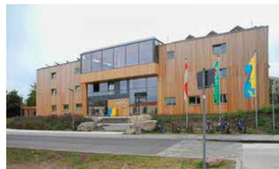
Die Kindertagesstätte „Burg“ vor und nach der Sanierung (Planung: Martin Wollensak mit Architekturbüro Holtz Gostomzyk)
