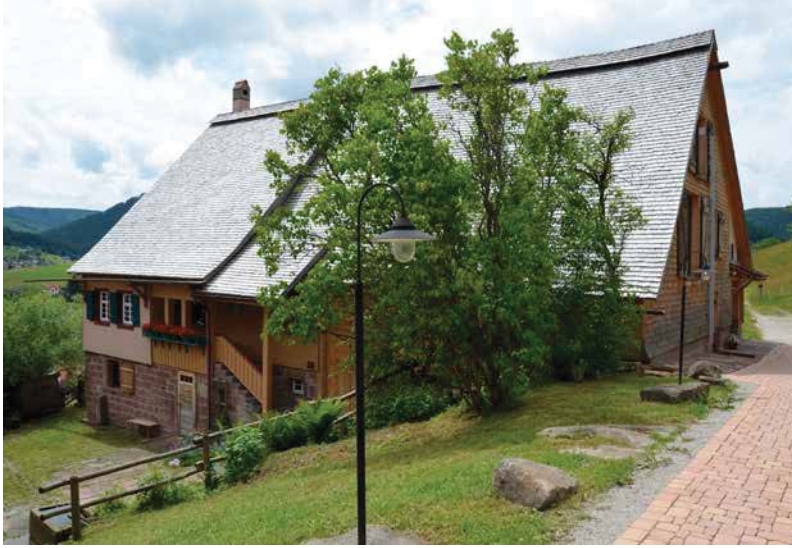
Der Morlokhof im oberen Murgtal ist einer der ältesten noch vollständig erhaltenen Bauernhöfe im Nordschwarzwald. Das ortsansässige Hotel Bareiss erwarb den Hof 2004 und führte anschließend eine durch das Landesdenkmalamt begleitete Sanierung durch. (Architektur: Architektin Sabine Rothfuß vom Büro Architektur con Terra)
