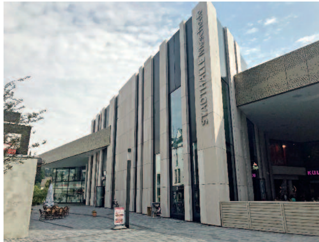
Die ehemalige Hertie-Immobilie in Meschede wurde zu einem Geschäftshaus mit Mieteinheiten und integrierter Stadthalle umgebaut
