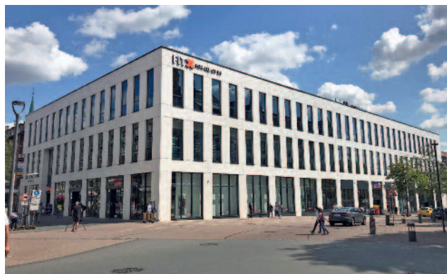
In Gladbeck wurde das ehemalige Hertie-Kaufhaus abgerissen und eine neue Einzelhandelsimmobilie errichtet
