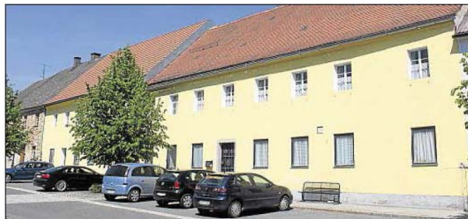
Einen zentral gelegenen Wohnraum für Senioren zu schaffen wird in diesem denkmalgeschützten Gebäude am Marktplatz in Winklarn untersucht. Ähnliche Bemühungen laufen auch in weiteren Kommunen der Leerstandsoffensive. Bild: hzf
