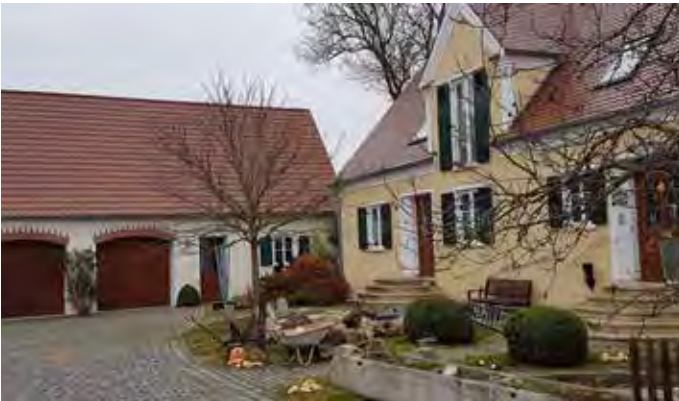
Abb. 29: Gebäudesanierung im Schrattenhofener Ortskern
