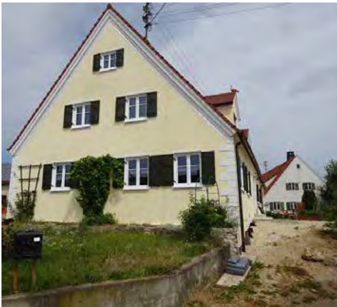
Abb. 13: Ein gelungener Ersatzbau im Ortskern von Ebermergen
