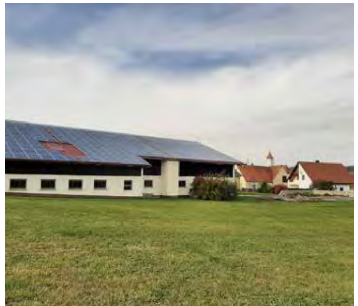
Abb.27: Mastbetrieb in Ortsnähe
