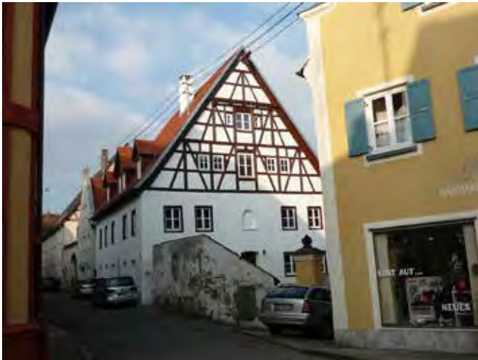
Abb. 28: Gebäudesanierung im Oettinger Stadtkern
