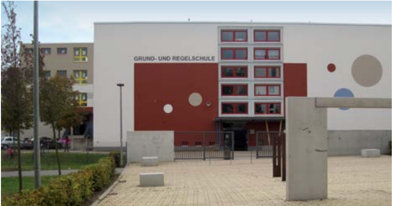
Die hochwertige Sanierung von Schulen, hier Nordhausen Ost, tragen zur Stabilisierung der Wohnsiedlungen bei.
