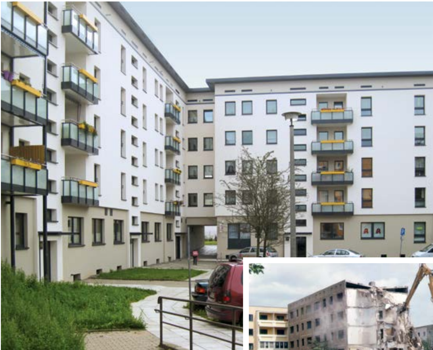
Oben: Sanierte Plattenbauten in Nordhausen Ost; rechts: Abriss in Wolfen-Nord
