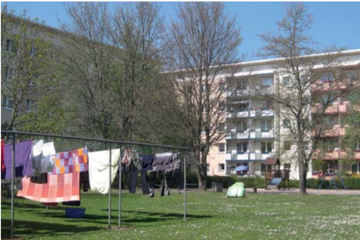
In vielen Kommunen sind Wohnsiedlungsbestände zur Deckung des Wohnungsbedarfs mittelfristig noch unverzichtbar.
