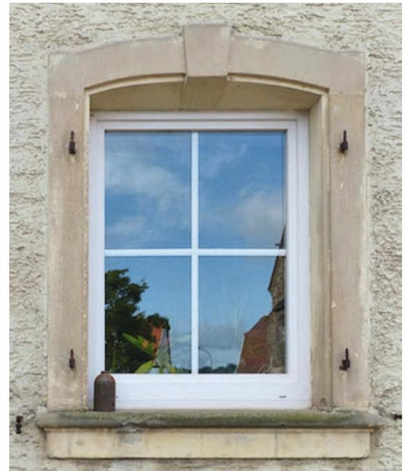
Mehrere Ersatzlösungen sind in der Folgezeit entwickelt worden, von denen eine stark verbreitet ist: die „innenliegende Sprosse“, die auch als „Helima-Sprosse“ bezeichnet wird. Bei diesem Fenster sind Aluminiumstreifen in den Scheibenzwischenraum von Isolierglasscheiben eingesetzt, die eine Sprossenteilung einer einzigen größeren Doppelglasscheibe vortäuschen. Sie werden spöttisch als „Sprossen in Aspik“ bezeichnet und fallen nicht nur an alten Bauernhäusern als unpassende Imitationen auf.
