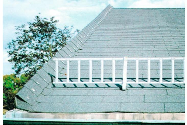
*Das sind Qualitätsunterschiede. In Material und Ästhetik. Ein altes Schieferdach in altdeutscher Deckung und eine Deckung aus Bitumenschindeln, zusammengetackert wie ein Pappkarton.*
