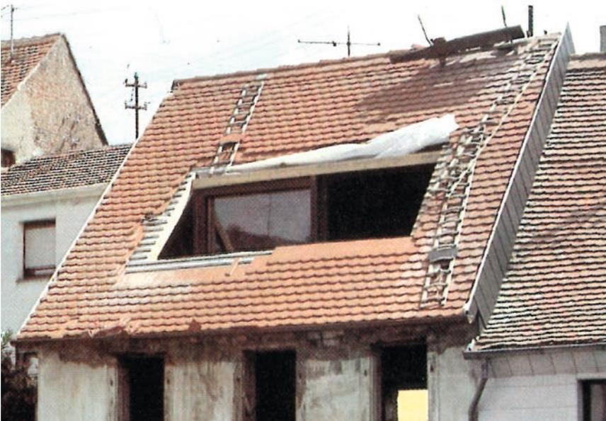
*Dacheinschnitte, Dachbalkone, Dachloggien garantieren die Zerstörung eines alten Daches. Da hilft dann auch eine Biberschwanzeindeckung nicht mehr. Wer eine solche Konstruktion wirklich für unumgänglich hält, sollte aus Rücksicht auf die Nachbarbebauung wenigstens die rückseitige Dachfläche in Anspruch nehmen.*
