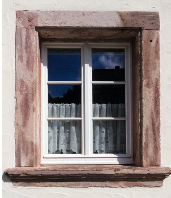
einzelnen Holzteile. Die Sprossen waren früher sehr schmal, weil sie nur kleine, leichte Scheiben zu tragen hatten. Wer heute neue Sprossenfenster anfertigen lassen will, wird mindestens doppelt oder dreifach isolierte
