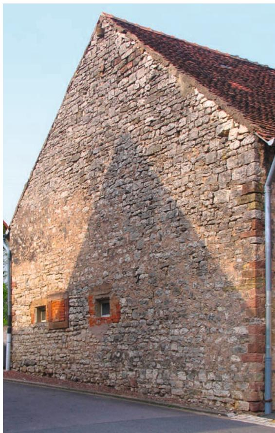
Eine Wärmedämmung der Fassadenwand eines Bauernhauses mittels eines Isolierputzes ist nicht möglich, ohne die Ästhetik der Fassade zu zerstören. Eine solche Isolierschicht muss, um die gewünschten Dämmwerte aufzuweisen, in einer Stärke aufgetragen werden, die die Gewände hinter den Putz zurücktreten ließe. Im Vergleich zu den üblicherweise über den Putz erhabenen Gewänden ein Negativ-effekt im doppelten Sinne.
