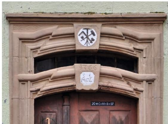
*Das Türgewände von 1766 weist einen steinernen Kämpfer auf, über dem ein Oberlicht angebracht ist. Im Schlussstein die Darstellung von Handwerkszeug der Steinmetze. Lacke oder Dispersionsfarben fördern stark die Verwitterung des Sandsteins und sollten daher keinesfalls verwendet werden.*
