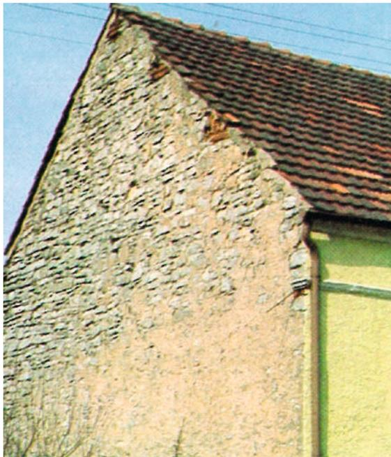
*Der Putz schützt das Mauerwerk. Wo der Putz defekt ist, werden die großen Fugen leicht ausgewaschen. Der gröbere Putz auf den Giebelwänden ist häufig weniger gepflegt. Ein grüner Fassadenanstrich ist für ein saarländisches Bauernhaus nicht typisch.*
