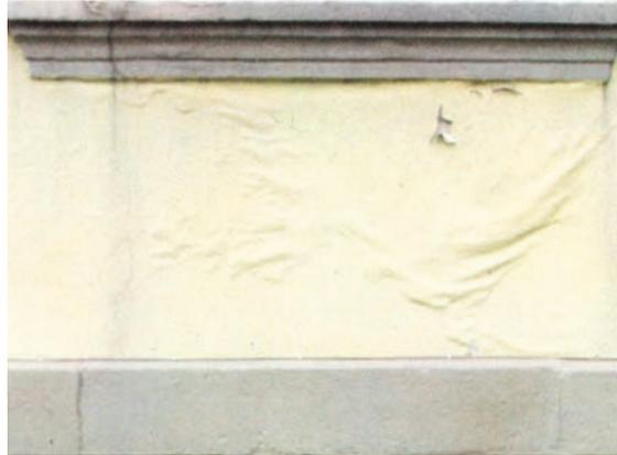
*Wasserdichte Farben schaden nicht nur dem Putz und dem Mauerwerk, sondern sehen als Wassersäcke an der Wand oder abblättern auch nicht gerade einladend aus.*
