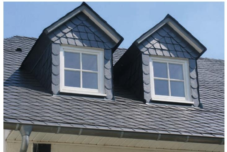
*Schiefer in Altdeutscher Deckung: Das wichtigste Merkmal der Altdeutschen Deckung besteht darin, dass die einzelner Decksteine individuell schuppenförmig von Hand geschlagen sind, während die einzelnen Steine bei der Schablonendeckung sämtlich gleichgeformt sind. Das Verlegen in altdeutscher Deckung setzt hohe Qualifikation und Erfahrung der Schieferdecker voraus.*
