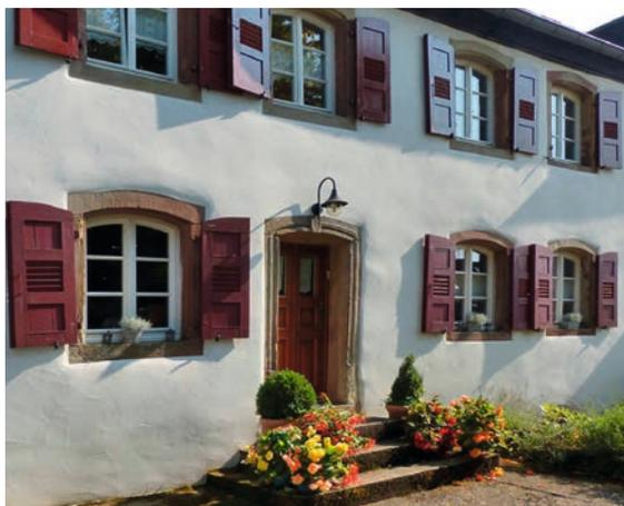
*Die eigenartig sanft geglättete Oberfläche des Fassadenputzes kommt dadurch zustande, dass viele Lagen Kalkfarbe übereinanderliegen.*
