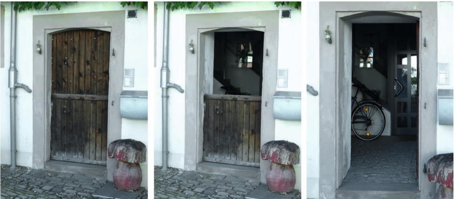
*Durch die „Wolfesheimer-Stall-Haus-Tür“ ist die funktionale Haustür um einige Meter nach hinten bis zur Treppe versetzt. Dadurch wurde ein Vorraum vor der Haustür gewonnen, der zum Abstellen von Gerät und Waren genutzt werden kann.*
