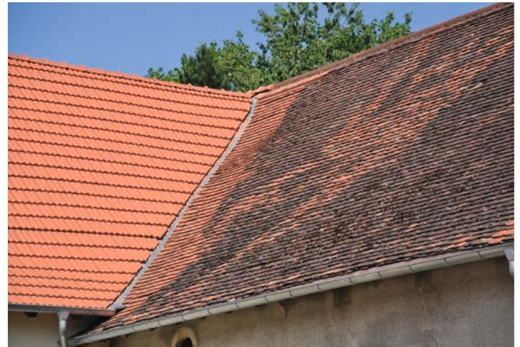
*Alte Dachziegel – 3 Arten alter Dachziegel auf einem Dach: oben: alte Biberschwänze, unten links: Doppelmuldenziegel, unten rechts: Dachpfannen*
